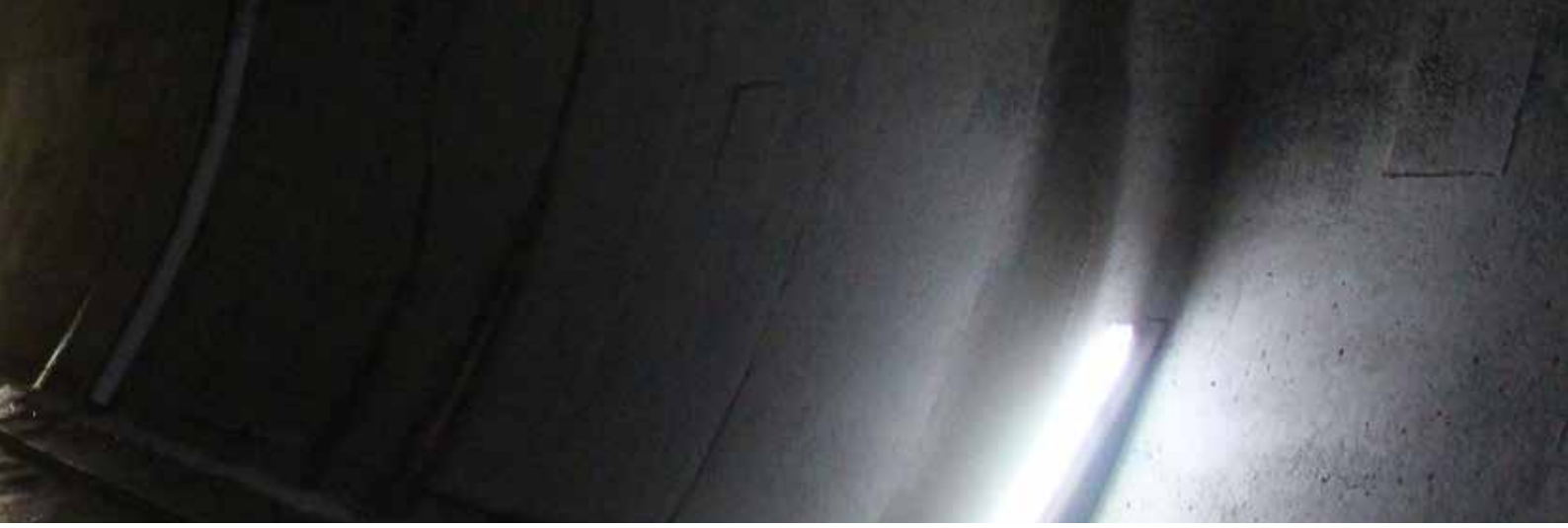
Entleerter Unterwasserkanal im Kraftwerk Martina während der Revisionsarbeiten im 2018.
