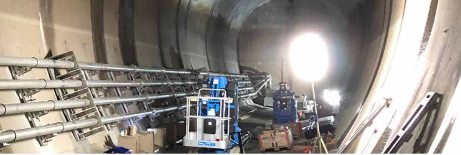
Einbau neues Kühlwassersystem im 2018.
