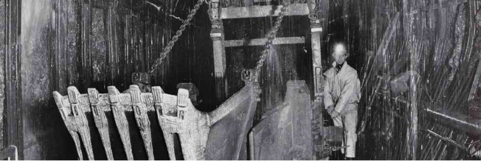
Bau des Kraftwerks Martina von 1989 - 1994.
