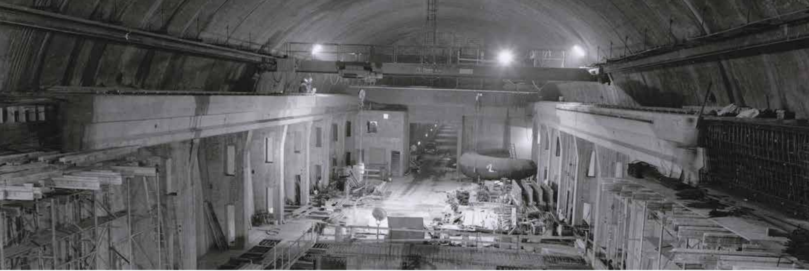
Bau des Kraftwerks Martina von 1989 - 1994.
